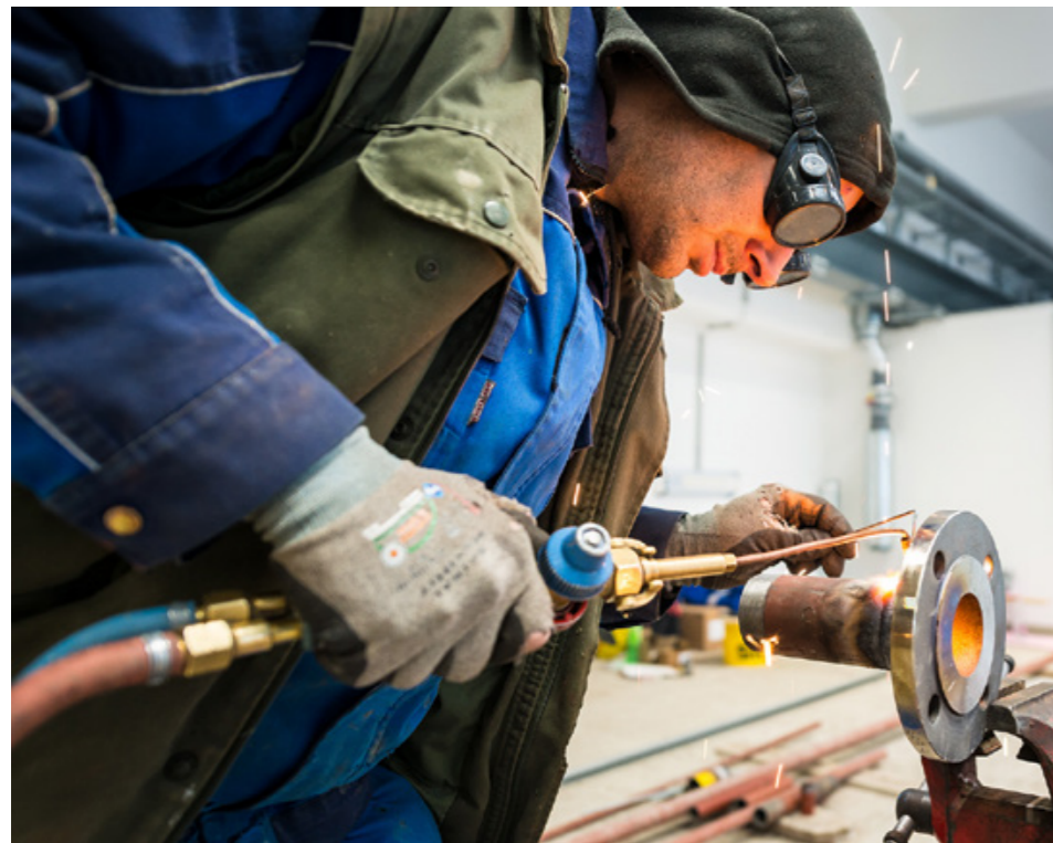
Im Rahmen des Projekts BaMa werden Energiefresser mittels Monitoring ermittelt. Bild: TU Wien, Matthias Heisler/goemb.at
